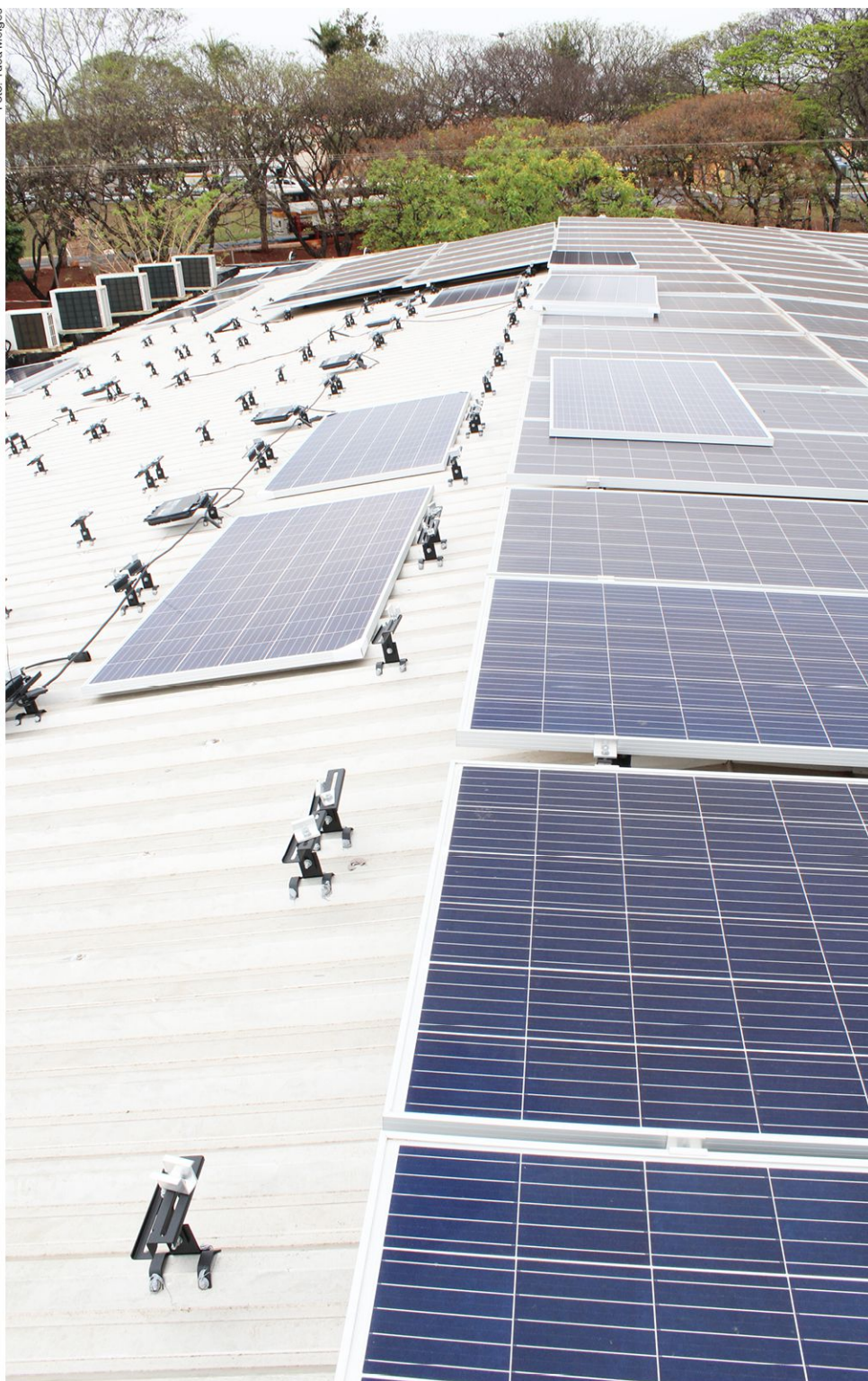
Painéis instalados no teto da Associação agora ampliando para toda a entidade
